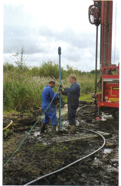
Installatie van glasvezelkabels aan de buitenzijde van een peilbuis voor temperatuurmonitoring.
